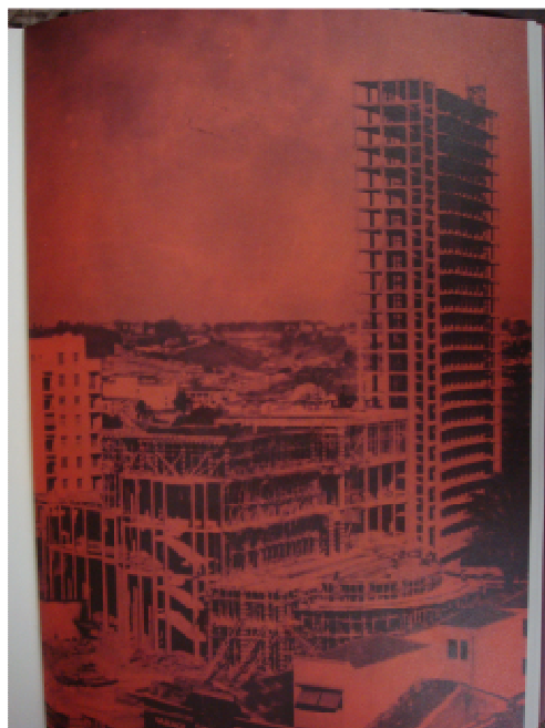
Construção da BMA, por volta de 1940.
