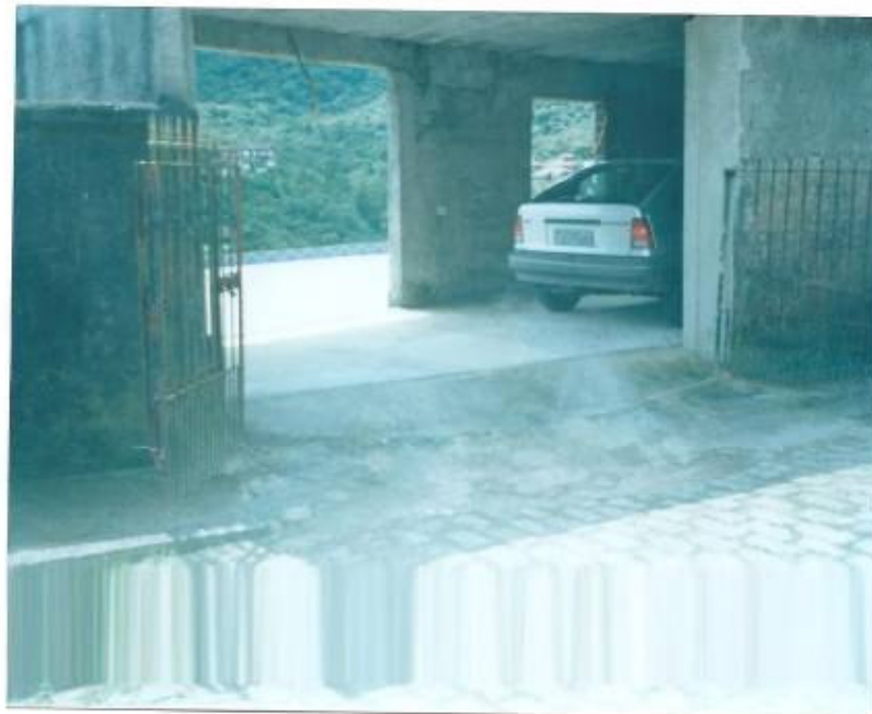
FOTO 3 – Vista da Entrada da Garagem (Rua João Antunes)
