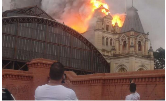
Figura 10: Incêndio no Museu da Língua Portuguesa
