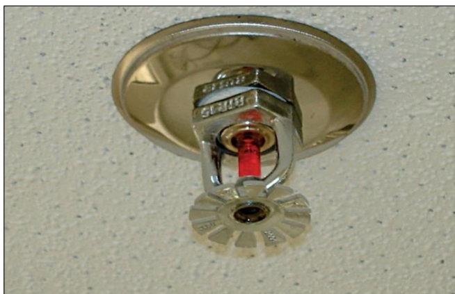
Figura 58: Chuveiro automático.
