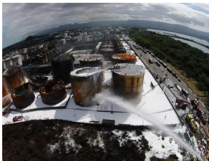
Figura 59: Incêndio em parque de tanques
