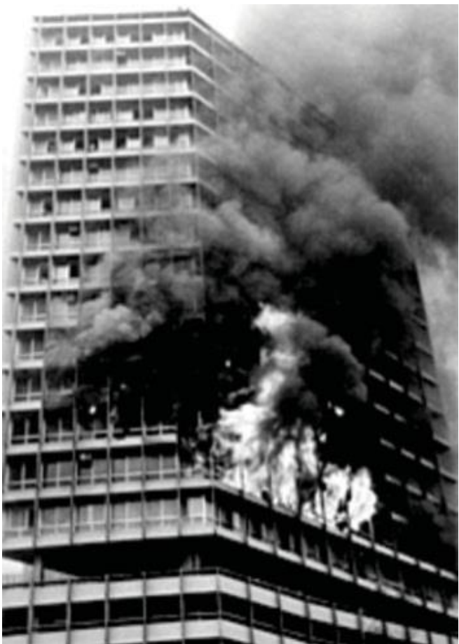
Figura 4: Incêndio no Edifício Joelma
