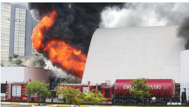
Figura 9: Incêndio no Memorial da América Latina
