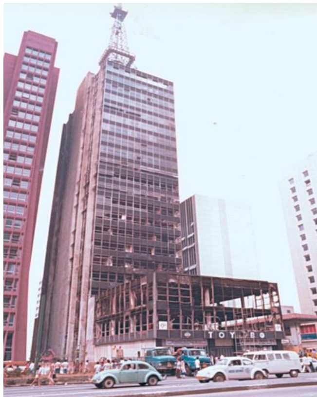
Figura 5: Incêndio no Edifício Grande Avenida
