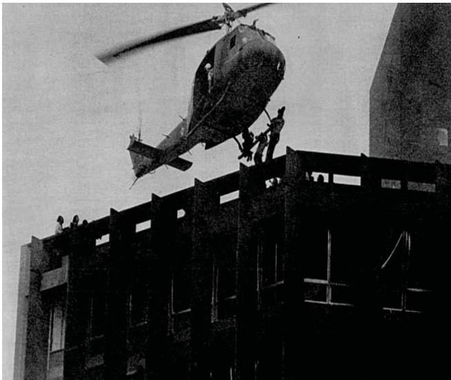
Figura 3: Tentativa de salvamento aéreo no Edifício Joelma.
