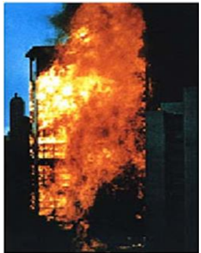
Figura 2: Incêndio no Edifício Andraus
