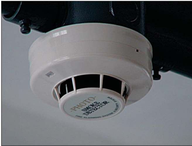
Figura 47: Detector de incêndio.
