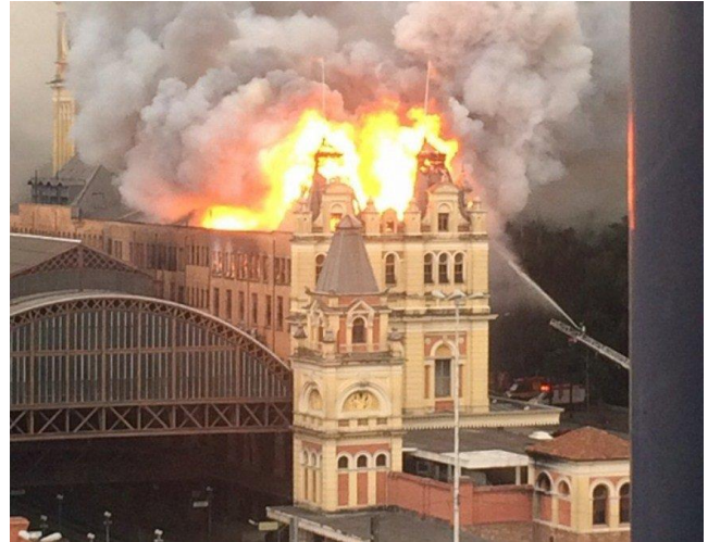
Figura 11: Incêndio no Museu da Língua Portuguesa
